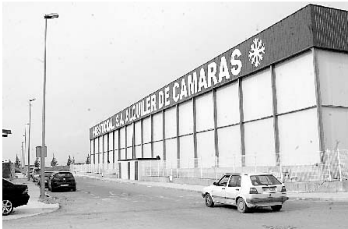
INSTALACIONES. Están ubicadas en el polígono industrial de Alhama de Murcia. / VICENTE VICENS/AGM
